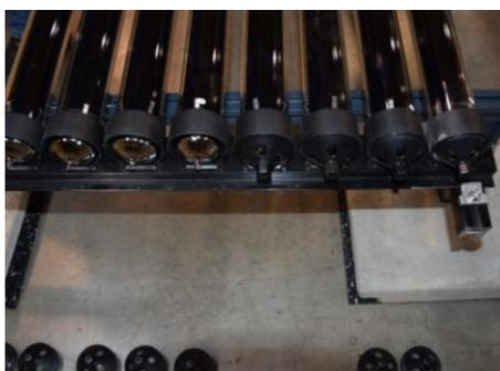
Sichern Sie die Modulfelder jeweils oben und unten gegen Verrutschen. Hierzu können Sie bei de Profilschienen beigelegten Schrauben aussen – unten montieren.
