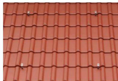
Sollten Sie weitere Kollektoren installieren, nutzen Sie oben genannte Vorgehensweise für die Anbringung weiterer Dachhaken.
