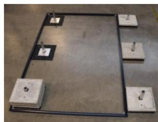
Fädeln Sie die Schrauben ein (Achtung Mutter + Scheibe immer aussen) und verteilen Sie die unterschiedlich langen Standschienen zu den Grundplatten.
