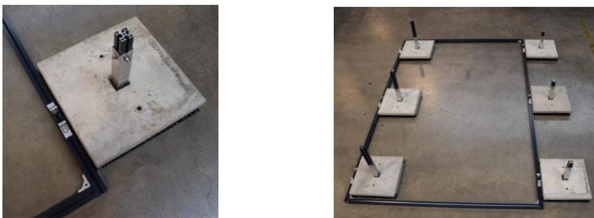
Der Kollektor-Modulrahmen ist komplett vormontiert. Durch den Transport, ist es jedoch möglich, dass sich die Winkel etwas verschoben haben. Dies ist zu korrigieren.
