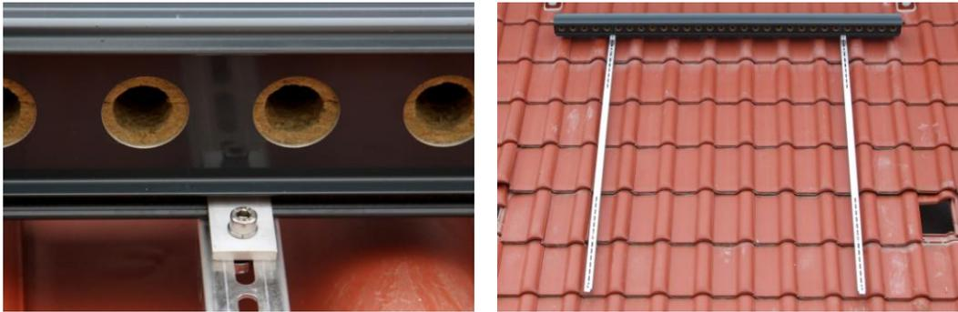
Nehmen Sie nun den unteren Teil der Fußschiene (3) zur Hand und legen Sie diesen mit mittiger Ausrichtung auf die Seitenschienen (2).
