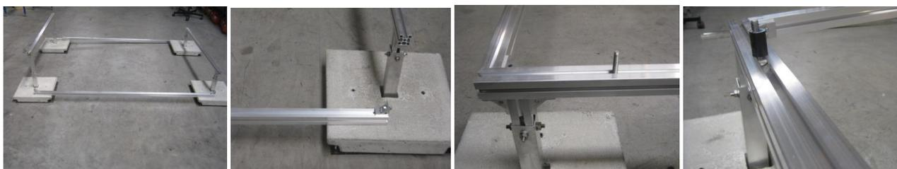
Legen Sie die Seitenschienen (U-Profile) aus den Modulbausätzen auf und befestigen Sie diese lose mit Scheiben und Muttern (Befestigungsset ST-ADM-2BM).
