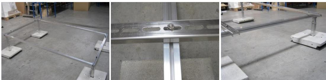
Zur Montage des Sammlerkastens schrauben Sie die Klemmhalter in der 1. und 5. Lochung im oberen Teil der beiden Schienen lose an. Verwenden Sie hierfür jeweils eine Inbusschraube M8 x 25, einen Federring M8, einen Klemmhalter und eine Schiebemutter. Danach den Sammlerkasten auflegen und ausrichten, so dass die Seitenschienen jeweils zwischen der zweiten und dritten Röhre positioniert sind. Anschließend die Klemmhalter an den Seitenschienen festschrauben.
