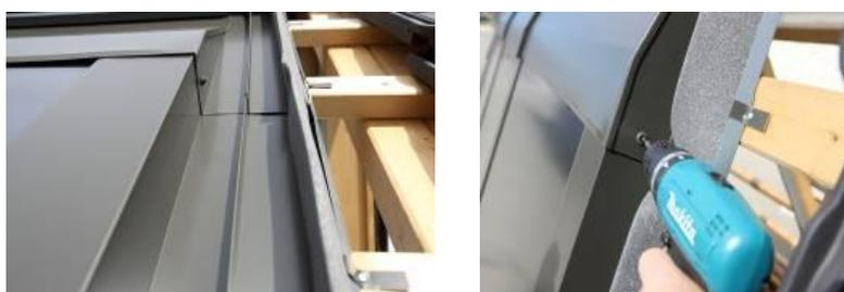
**Eindeckrahmenunterteile, -seitenteile und –verbindungsleisten** miteinander verschrauben ( Blechschraube 3,5x16 ).
