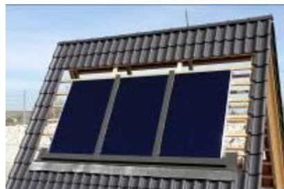
**Eindeckrahmenseitenteile** links und rechts aufstecken einrasten und ausrichten.
