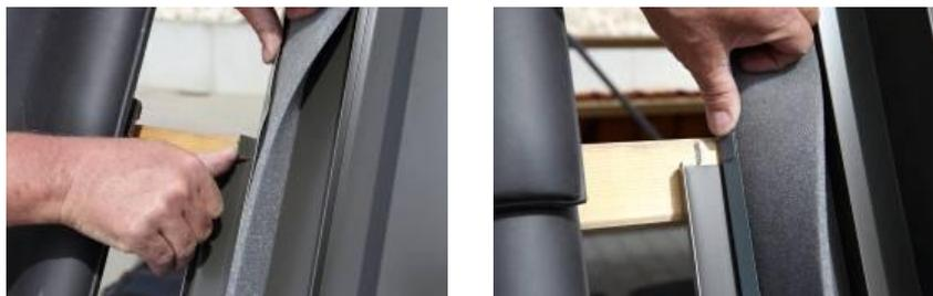
Fehlende Dachziegel andecken und bei Bedarf fachgerecht zuschneiden. Folie vom selbstklebenden Dachanschlussstreifen abziehen und Streifen an die Ziegelform anformen.
