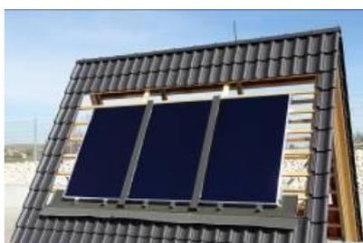
**Eindeckrahmenunterteile** aufstecken, einrasten und ausrichten.
