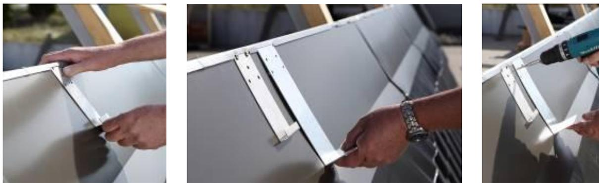
**Flachkollektoren** von links beginnend in die Lattenanker einlegen und ausrichten, so dass der Abstand von Lattenanker zur Außenkante des Kollektors auf beiden Seiten gleich ist.
