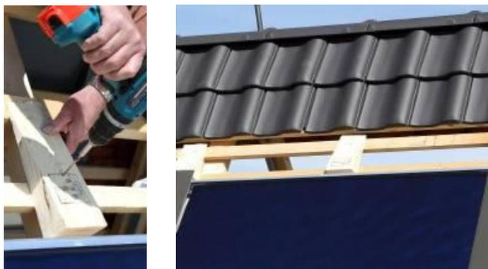
**Eindeckrahmenkopfhauben** links, Mitte und rechts aufstecken einrasten und ausrichten.
