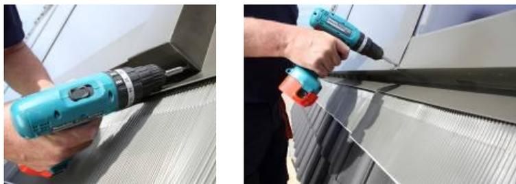
**Eindeckrahmenunterteile** und **Eindeckrahmenseitenteile** sind links und rechts durch Umlegen der Blechlasche miteinander zu verbinden.
