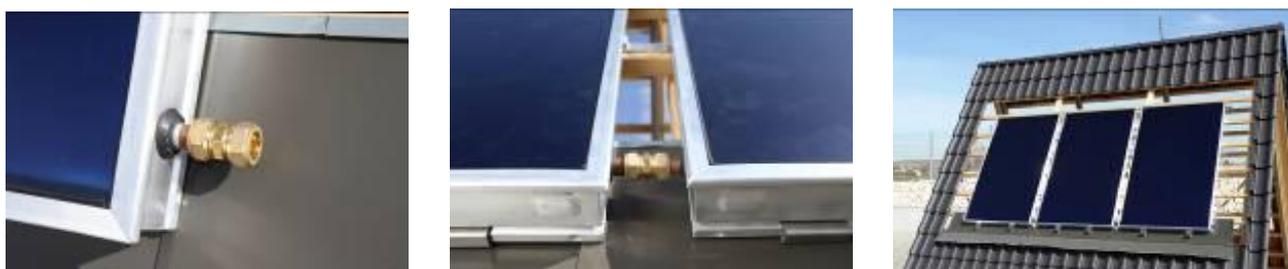
Sind alle **Flachkollektoren** montiert, werden alle Klemmringfittings (Winkel, T-Stück mit Tauchhülse, Endkappen) aufgesteckt und ausgerichtet. Danach alle **Klemmringverschraubungen** gleichmäßig anziehen.
