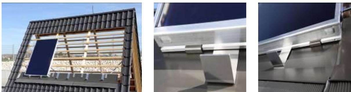
**Flachkollektoren** mit **Alu Z-Profilen** beidseitig oben und unten an der Lattung verschrauben (Spanplattenschraube 6x60).
