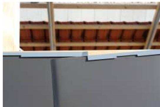
**Lattenanker** und **Schneelastwinkel** in die Ausstanzungen schieben und verschrauben (Spanplattenschrauben 5x35). Zur optimalen Ausrichtung der Lattenanker empfehlen wir, eine Richtschnur zwischen dem ersten und letzten Lattenanker zu spannen.
