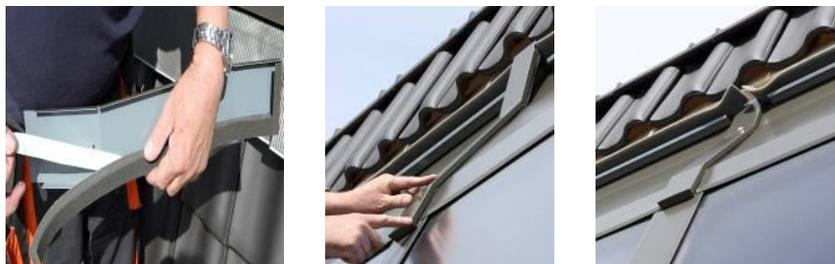
**Eindeckrahmenseitenteile** und **Eindeckrahmenkopfhauben** mit Nagellaschen an der Lattung fixieren, **Eindeckrahmenseitenteile** und **Eindeckrahmenkopfhauben** verschrauben (Blechschaube 3,5x16).
